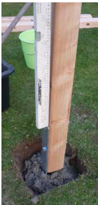
Abb. 12: Ausrichten der Pfosten mit Wasserwaage
