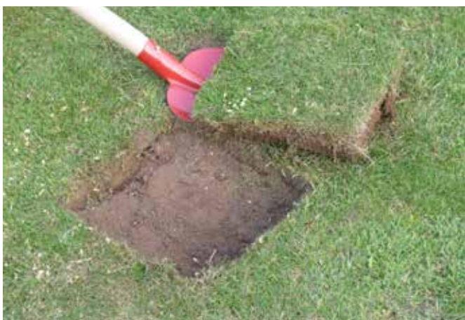
Abb. 10: Entfernen der Rasenschicht
