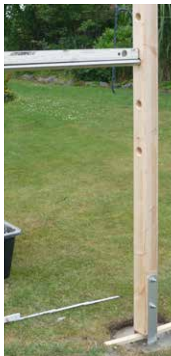
Abb. 13: Ausrichten der Turnstange mit Wasserwaage
