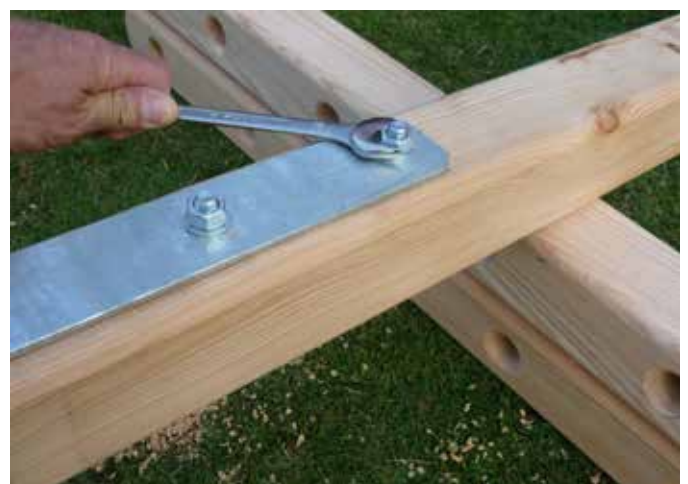
Abb. 7: Verschraubung Pfosten mit Träger
