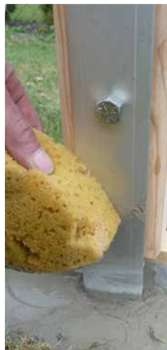
Abb. 15: Säubern der Pfostenträger von Betonrückständen
