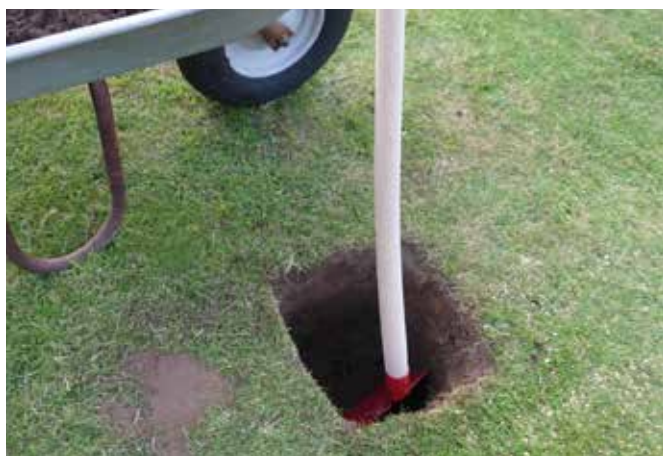
Abb. 11: Ausheben der Fundamentlöcher (30 x 30 x 60 cm)
