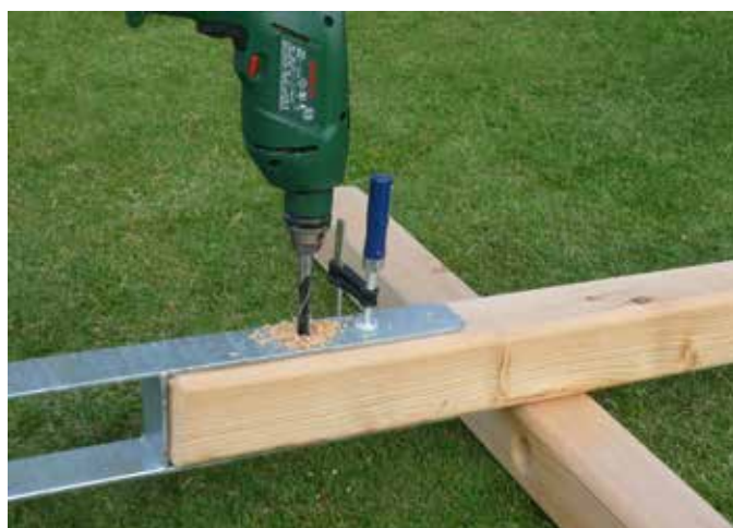
Abb. 6: Ausführung der 12 mm Bohrungen
