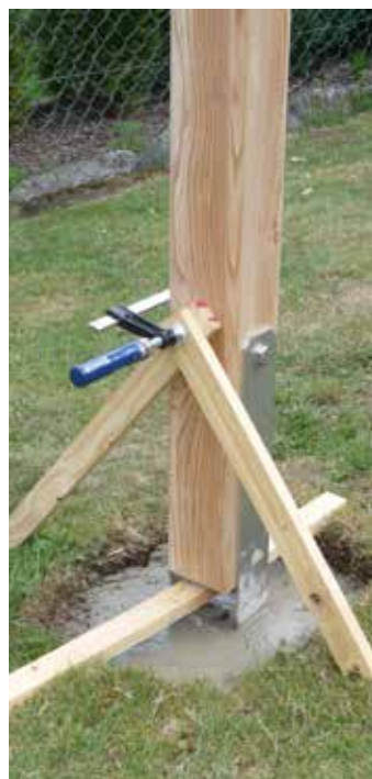
Abb. 14: Fixieren der Pfosten mittels Latten o.ä.
