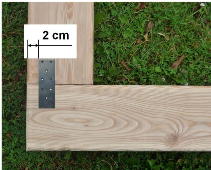
Abb. 7: Verschraubung der Sitzbretter mittels Holzverbinder und den Schrauben 4,5x25 mm, jeweils 3 Stück pro Seite. Die Oberseite der Sitzbretter liegt hierbei auf dem Rasen.
