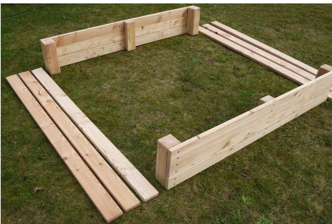
Abb. 4: Zu Beginn werden die beiden gegenüberliegenden Seiten montiert. Anschließend können die weiteren Seitenbretter und Mittelpfosten eingebaut werden.
